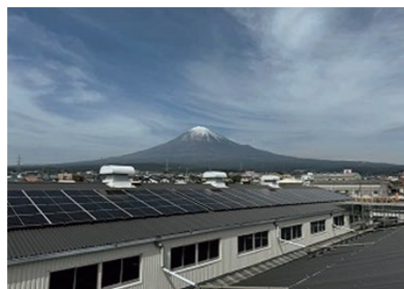
大宮精機では、全量自家利用の太陽光発電システムを導入し、工場の屋根には現在100キロワットの太陽光パネルを設置している
